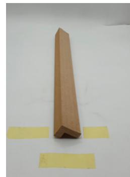
Misurazione del nastro della larghezza esatta della zona da rivestire
